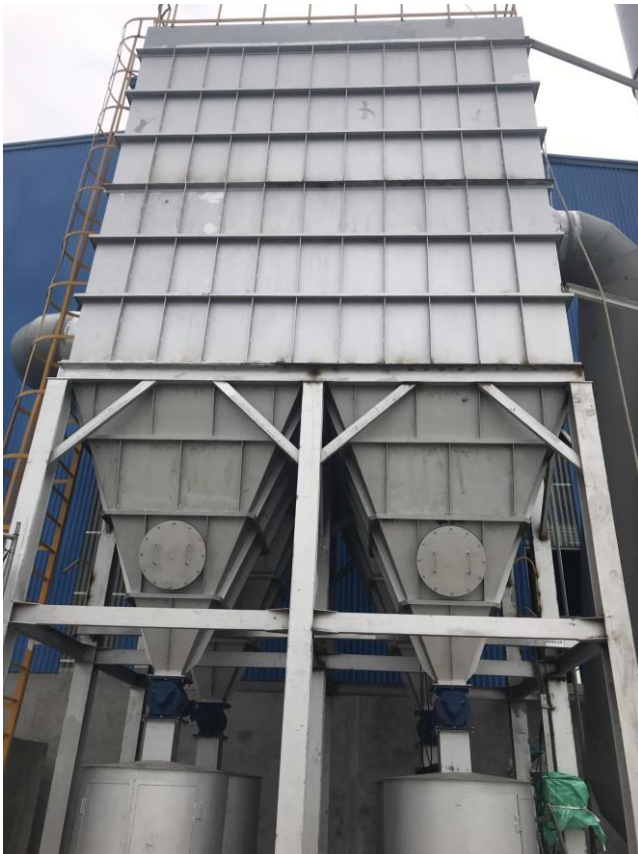
Hình 9: Hình ảnh hệ thống xử lý khí thải hệ thống tái chế nhôm
