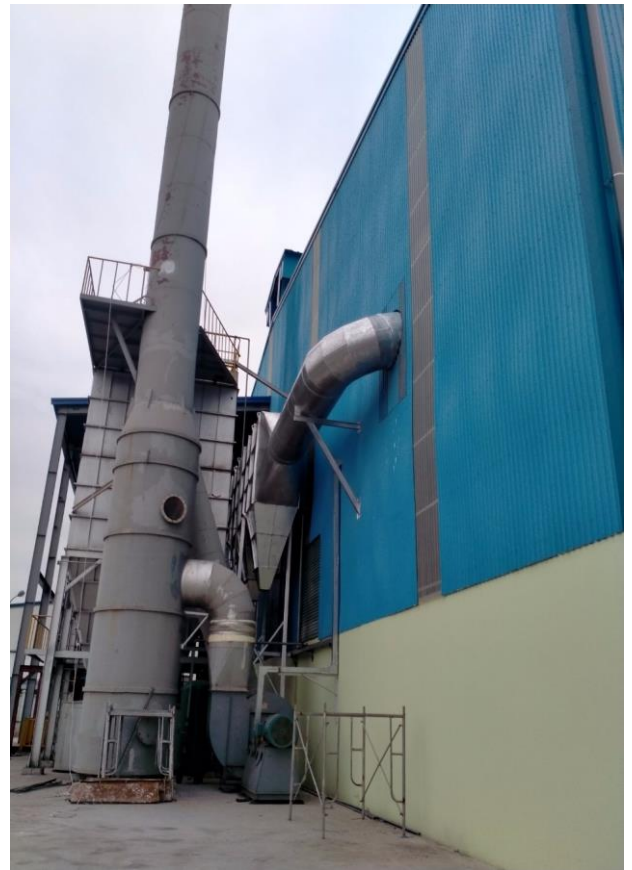
Hình 9: Hình ảnh hệ thống xử lý khí thải hệ thống tái chế nhôm
